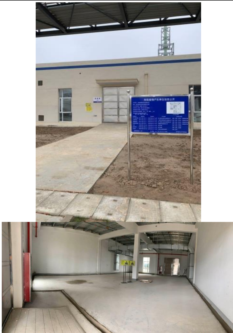
图 3.1.5-4 现有已建危废仓库
